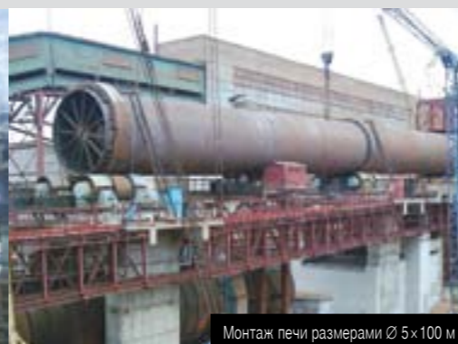
Монтаж печи размерами Ø 5×100 м
